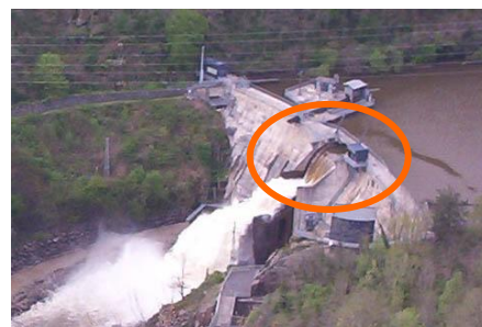
Photo 3 : Crête de déversement, barrage du Saillant
