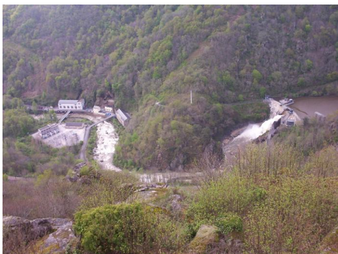
Photo 4 : Barrage et centrale hydroélectrique du Saillant
