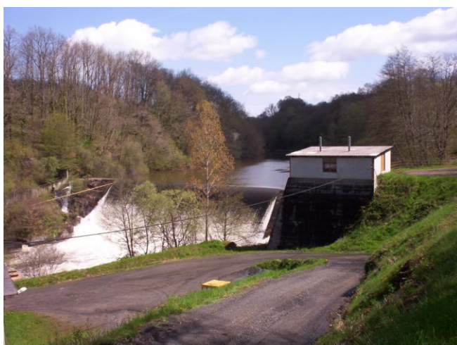
Photo 5 : Barrage du Gour Noir
